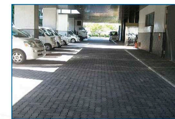
じょうすい ち 浄水池 きれいになった水を溜めておき各家庭に送ります。(駐車場の地下に1000m 3 のタンクが2つあります。)
