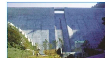
しゅすい しせつ 取水施設 ダムから水を取ります。
