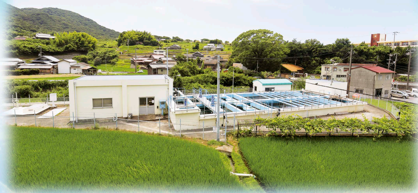
室津浄水場(淡路市室津)
