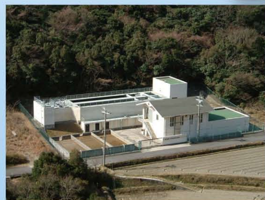
●河内谷浄水場
