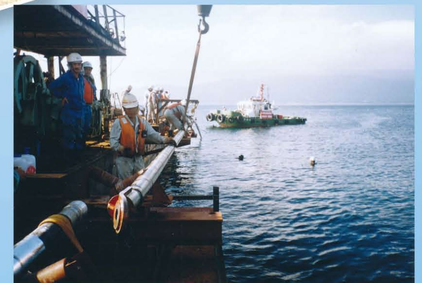
●沼島海底送水管の布設状況
